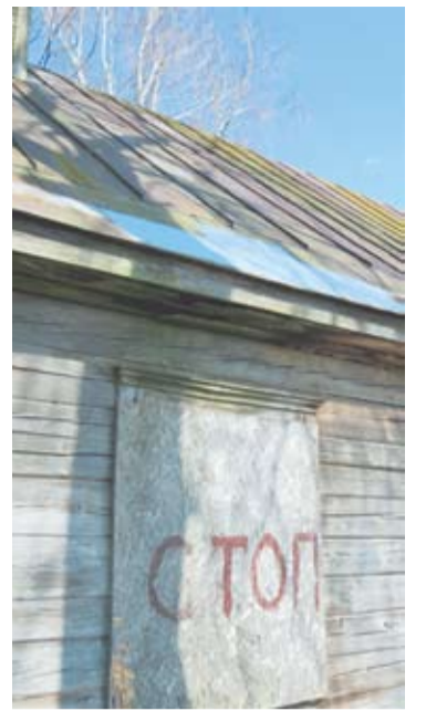
Skardos lakštais užtaisytas stogo dangos plyšys.
